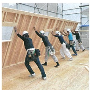
頑丈な2×4の壁を一気に建て起こす
